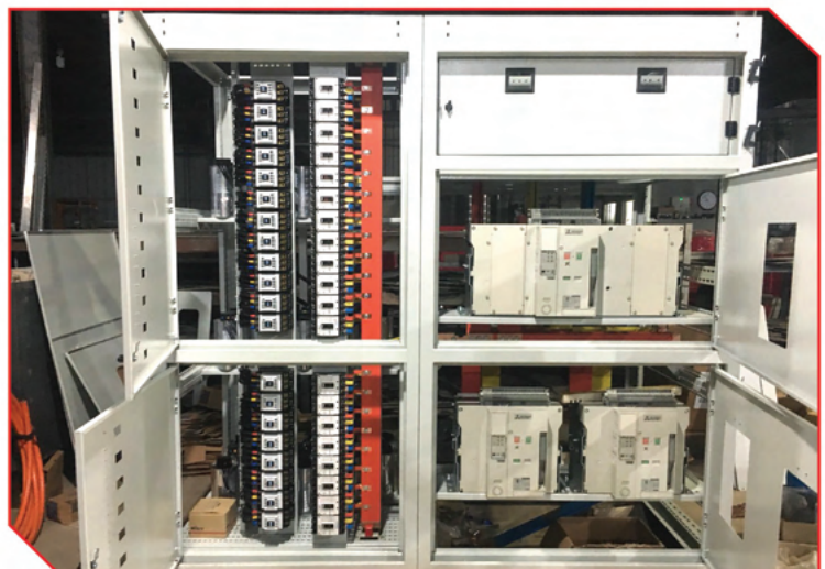
Tủ phân phối tổng + tủ tụ bù - Total distribution cabinets + capacitor cabinets
