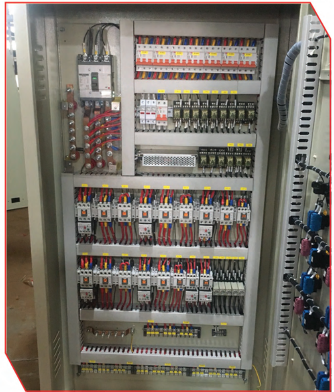
Tủ điều khiển bơm - Pump control cabinet
