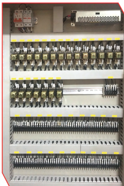
Tủ điều khiển van điện - Electric valve control cabinet
