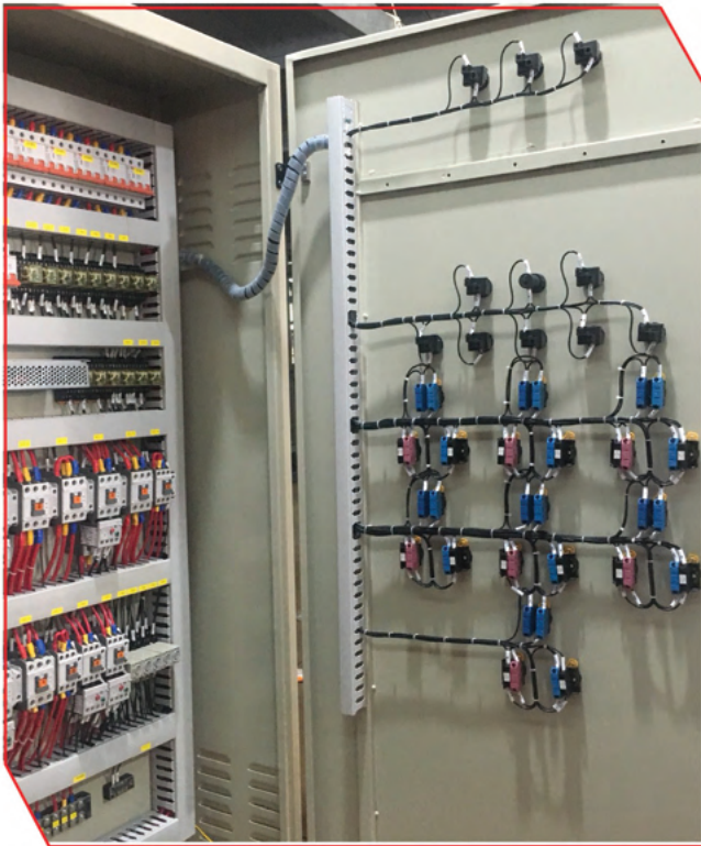
Tủ điều khiển bơm - Pump control cabinet
