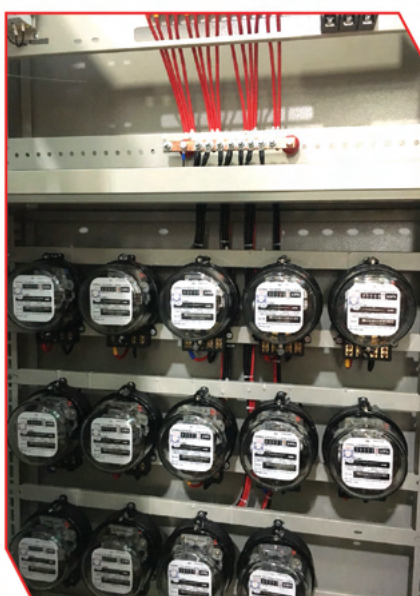
Tủ công tơ 1 pha - 1 phase meter cabinet
