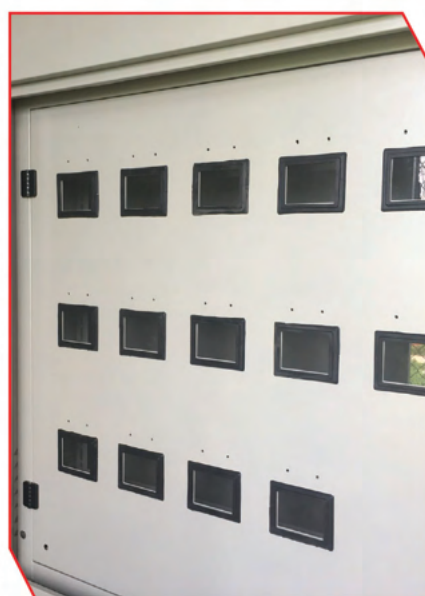
Tủ công tơ 1 pha - 1 phase meter cabinet
