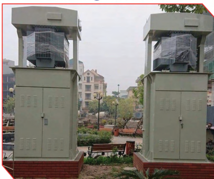
Trạm trụ hợp bộ composite station station
