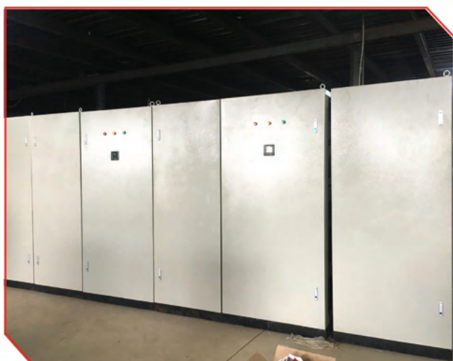
Tủ hạ thế tổng loại ghép khoang Low-voltage cabinet with type of compartment
